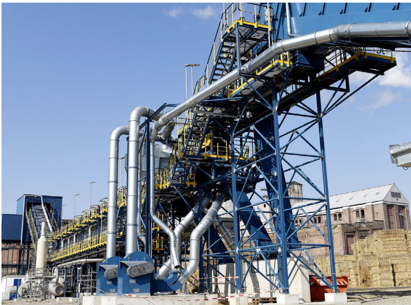
Über ein riesiges Stroh-Förderband gelangen die Ballen direkt vom Lagerplatz in die Produktion. Copyright: Essity / Tröster
