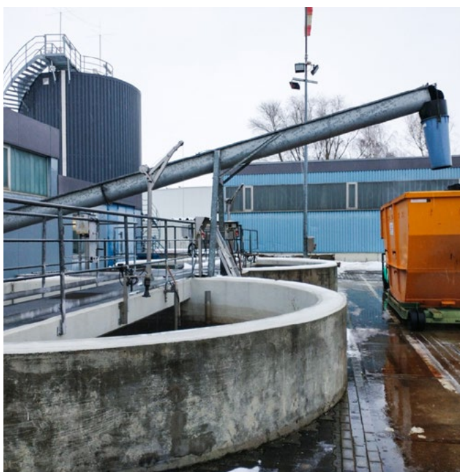
Projekt RoKka: Hochlastfaulung auf der Kläranlage Erbach (Donau), Grundlage für den Ausbau der Kläranlage zur Bioraffinerie © Fraunhofer IGB
